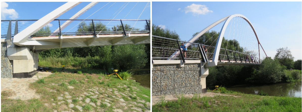
Obr. 5: Dva radary IBIS-S a IBIS-FS umístěné pod nosnou konstrukcí lávky pro chodce přes slepé rameno Labe Jesípek u Hradce Králové.
