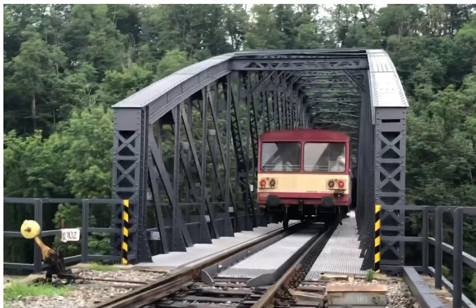
Obr. 42 – Přejezd železniční soupravy č. 05 proti směru staničení mostu, pohled na čelo soupravy před vjezdem na most a pohled na zadní část soupravy na mostu.
