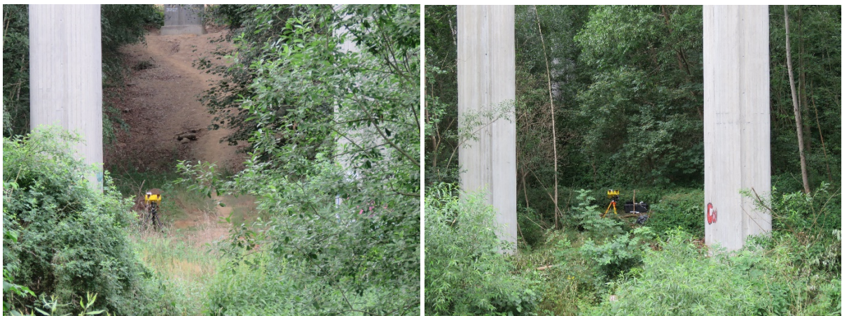
Obr. 4: Dva radary IBIS-S (vlevo) a IBIS-FS (vpravo) umístěné pod nosnou konstrukcí betonového silničního mostu u Pelhřimova.
