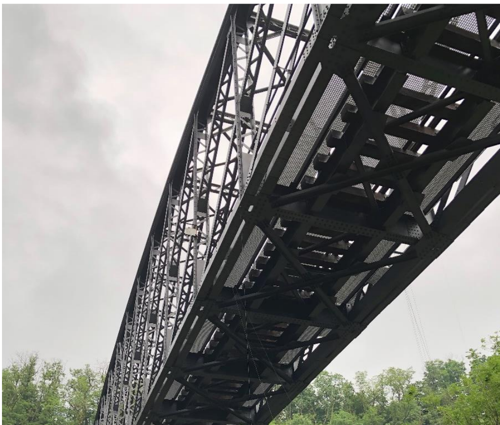
Obr. 3 – Spodní pohled proti směru staničení mostu na vodorovnou nosnou konstrukci.
