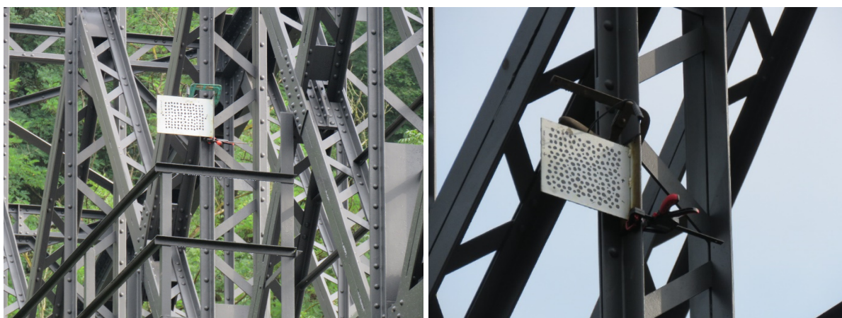
Obr. 11: Terč s kontrastním skvrnitým vzorem umístěný ve sledovaném bodu v polovině rozpětí (vlevo) a ve třech čtvrtinách rozpětí (vpravo) vodorovné nosné konstrukce ocelového železničního mostu přes řeku Sázavu v Ratajích.
