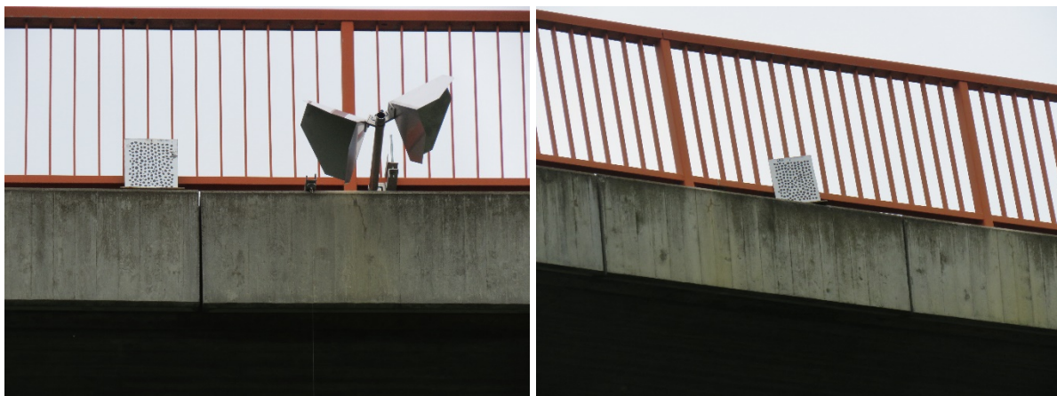
Obr. 10: Terče s kontrastním skvrnitým vzorem umístěné ve sledovaných bodech ve 4. poli silničního mostu u Pelhřimova.
