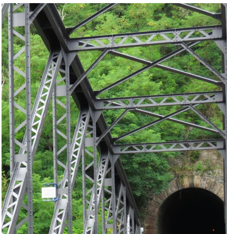
Obr. 4 – Spodní pohled proti směru staničení mostu horní pas, svislice a diagonály pravého hlavního nosníku a na horní zavětrování hlavních nosníků.
