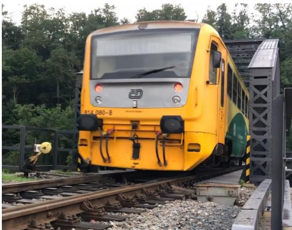
Obr. 34 – Přejezd železniční soupravy č. 04 proti směru staničení mostu, pohled na čelo soupravy před vjezdem na most a pohled na zadní část soupravy na mostu.
