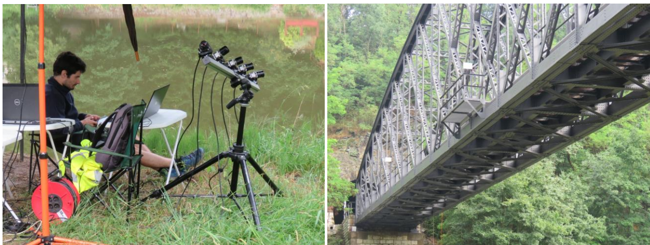
Obr. 7 – Pohled na kamery s objektivy použité pro DIC (vlevo) a na terče s kontrastním skvrnitým vzorem umístěné na 1. opěře (statický bod) a ve sledovaných bodech vodorovné nosné konstrukce v 1. čtvrtině a v polovině jejího rozpětí (vpravo).
